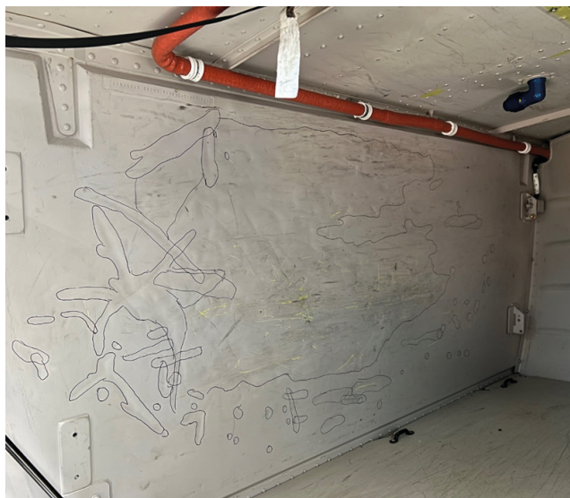
Zdjęcie 1 Wyraźnie widoczne liczne wgniecenia na obszarze całej ściany.
