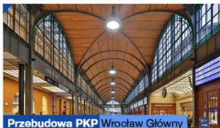
Przebudowa PKP Wrocław Główny
