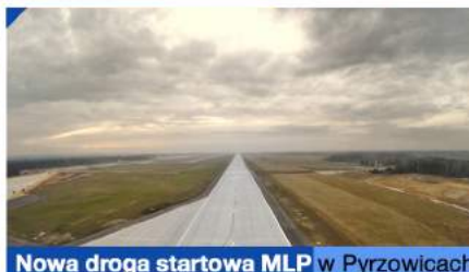
Nowa droga startowa MLP w Pyrzowicach
