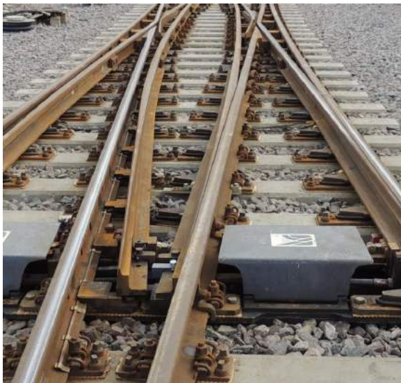
Rozjazdy Rkpd 60E1-190-1:9 zabudowane na stacji Świdnik
