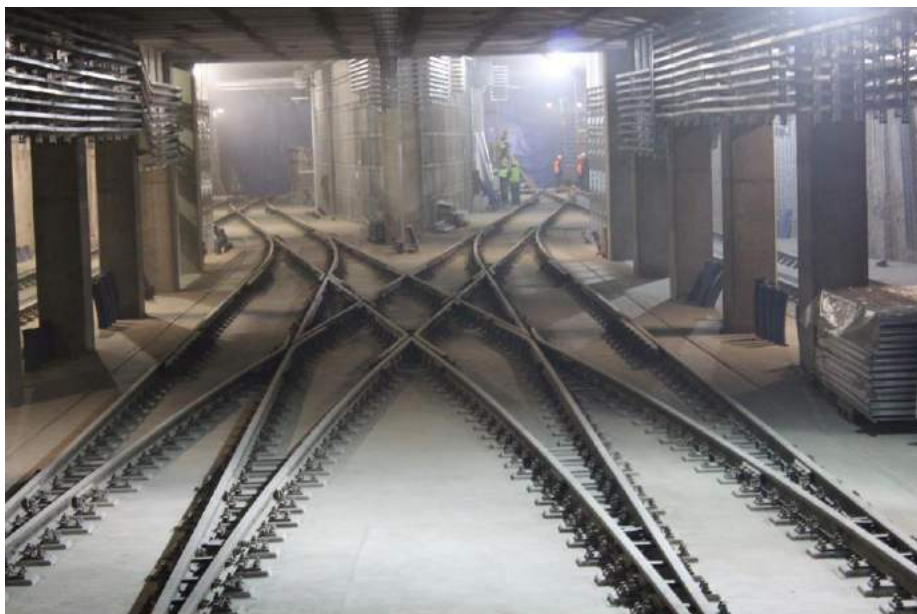
Przykład połączenia torowego na nawierzchni bezpodsypkowej.
