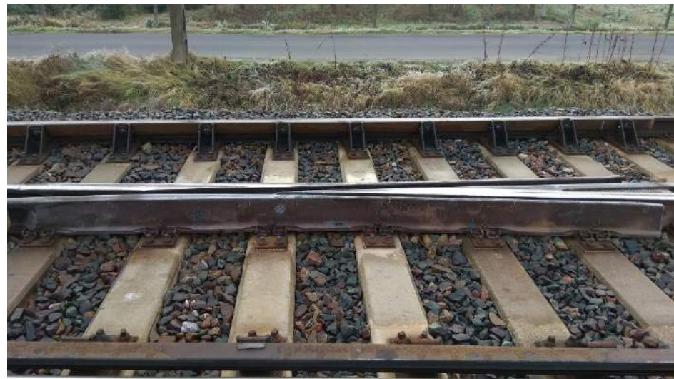
Przykład krzyżownic monoblokowych ze staliwa manganowego na stacji Bednary
