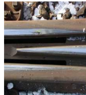
RCF an Flügelschienen
