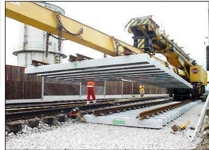
Kraneinbau auf der Baustelle
