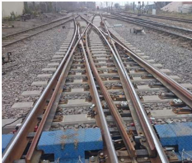
Rozjazdy Rkpd 60E1-190-1:9 zabudowane na stacji Świdnik
