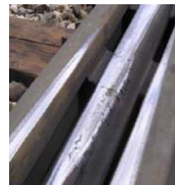
RCF an Flügelschienen
