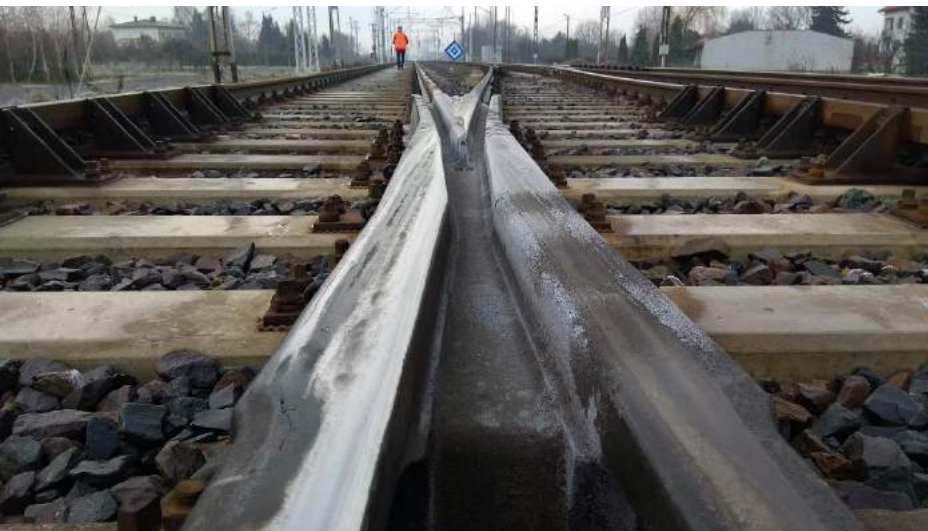
Przykład krzyżownic monoblokowych ze staliwa manganowego na stacji Bednary
