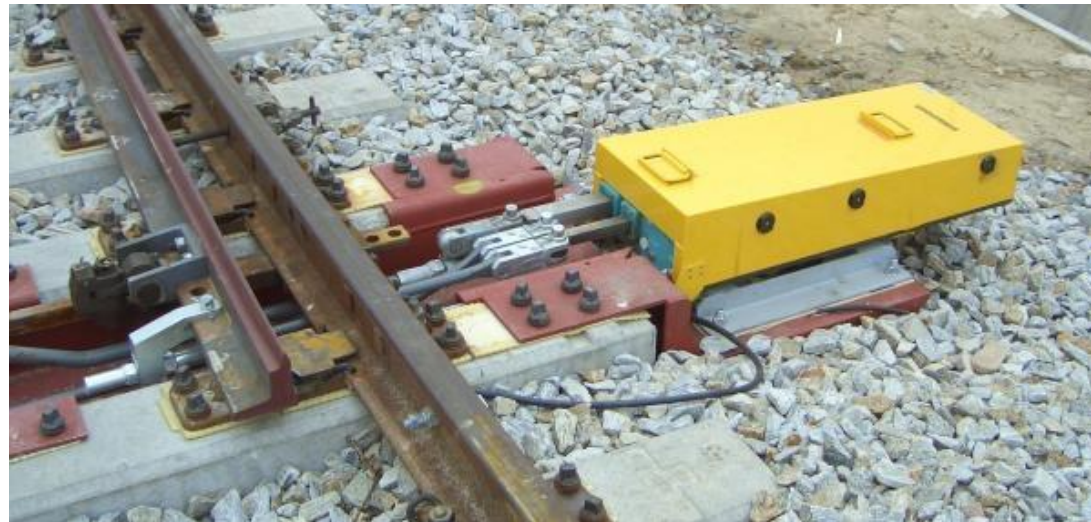
Podłączenie napędu do toru
