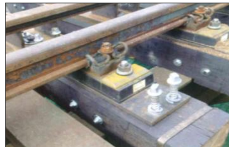
Abb. 14: Innbrücke bei Passau mit ERL 17,5 auf Holzbrückenbalken
